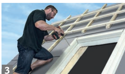
3 Rahmen auf dem Dach montieren Den Dämm- und Montagerahmen BGX auf das Dach setzen und verschrauben.
