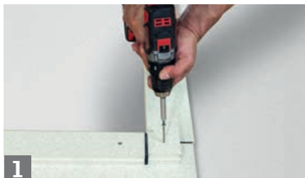
1 Rahmenprofile verbinden Die Profile einfach an den Ecken miteinander verschrauben.
