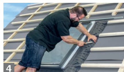
4 Fenster inkl. BDX und BFX montieren Abschließend muss das Fenster nur noch mit dem Dämm- und Anschluss-Set 1) wie gewohnt montiert werden.
