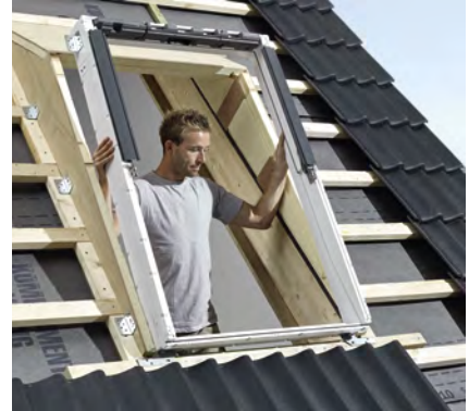
3. Fenster-Blendrahmen in die Dämmung einsetzen und verschrauben.
