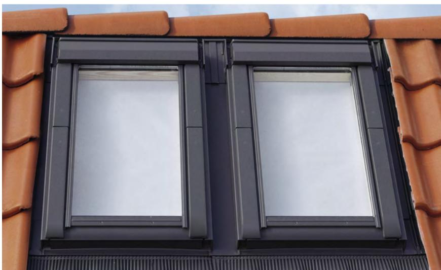
Einbau mit durchgehenden Firstziegel
