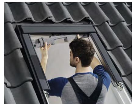
3. Anschließend den Dämmblock innen am Fenster gegen den im Lieferumfang enthaltenen austauschen.
