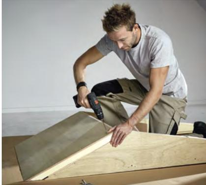
1. Die im Lieferumfang enthaltenen Dämmteile montieren.
