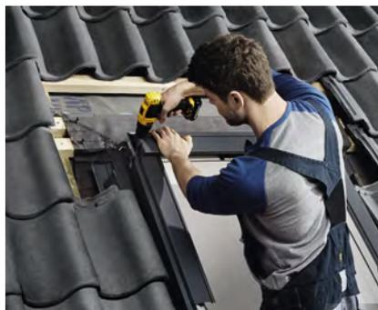
2. Markisenkasten ausbauen und gegen neuen Markisenkasten mit integriertem Lüftungselement tauschen.
